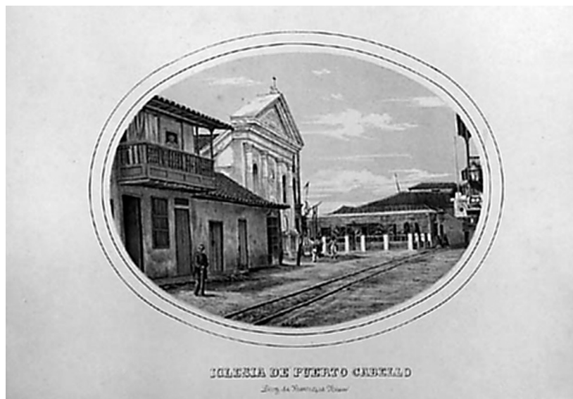
Obsérvase los rieles que corrían a lo largo de la Calle Colombia.
