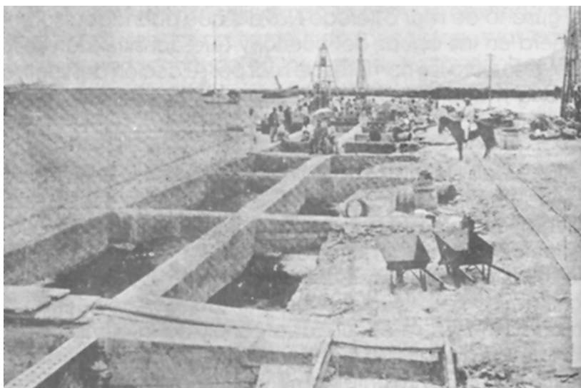
Detalle sobre los trabajos de embovedado
